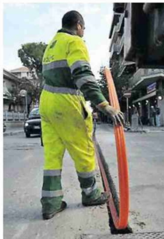
Scavi per la fibra ottica
