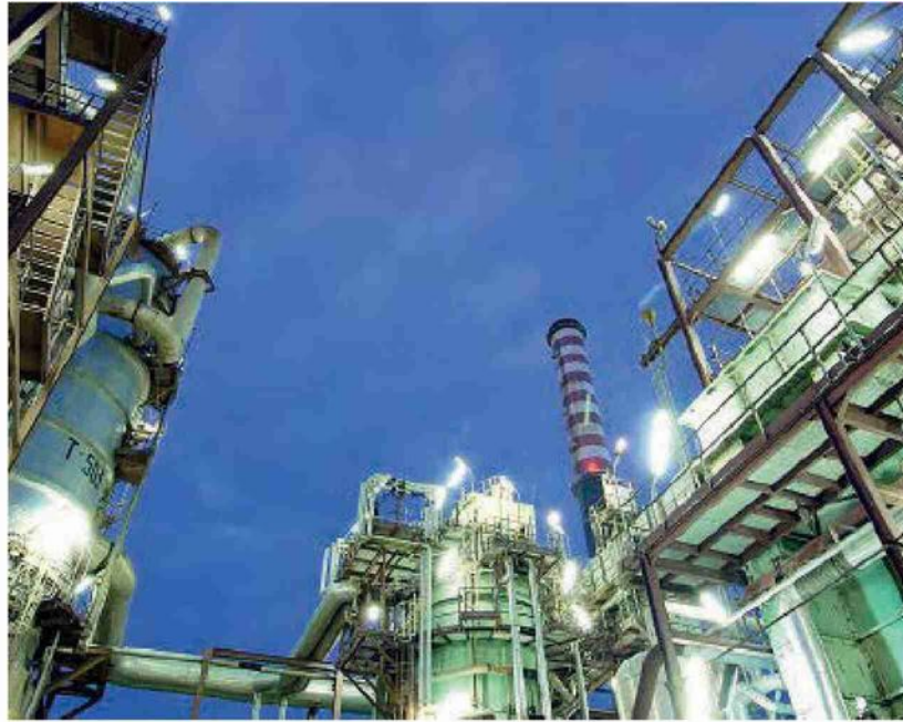
Una veduta della raffineria Isab di Priolo
