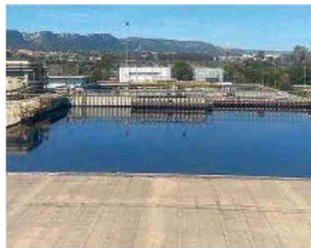
Le vasche del depuratore Ias
