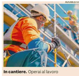
In cantiere. Operai al lavoro
